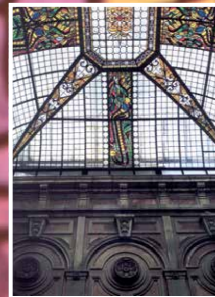
Vitral para plafón en patio principal Vidrios emplomados sobre estructura de acero 28 m 2 1986 Ciudad de México
