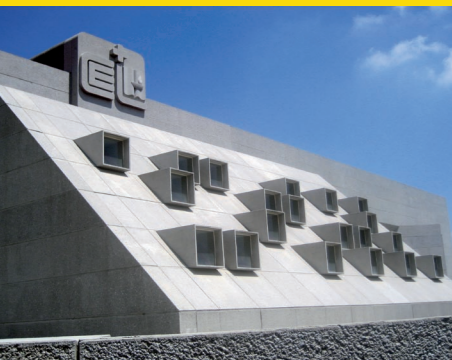
Vanos de iluminación, 2009. Archivo DACPAI. INBA.
